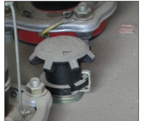
Abbildung 10: Transformator Stufenschalterstellung
